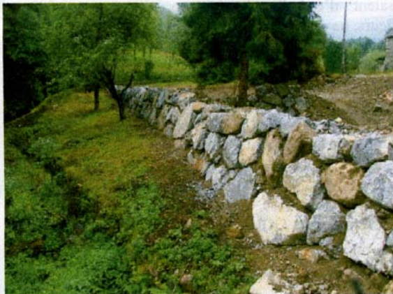
Enrochement de l'aire de stationnement de la future Mairie, à l'entrée du village.
