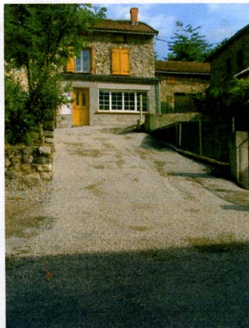
Goudronnage du quartier « Grill »
