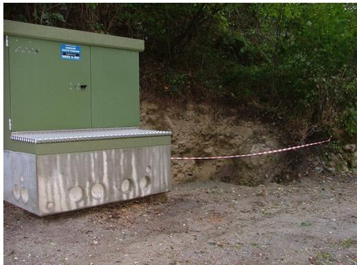
Chacun aura remarqué cette armoire électrique à l'entrée du village. Il s'agit d'une armoire de raccordement de la ligne moyenne tension qui permettra la jonction depuis l'arrivée de la centrale électrique de Carnières et des départs vers Gourbit et Rabat par le chemin du Carrier. Ce réseau sera enterré, pour des raisons de sécurité mais aussi de fiabilité. Cette opération garantira la distribution de l'énergie électrique notamment dans les périodes d'intempéries.
