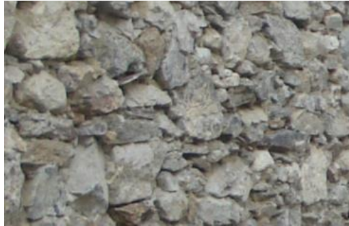
Mur en pierre brute hordée
