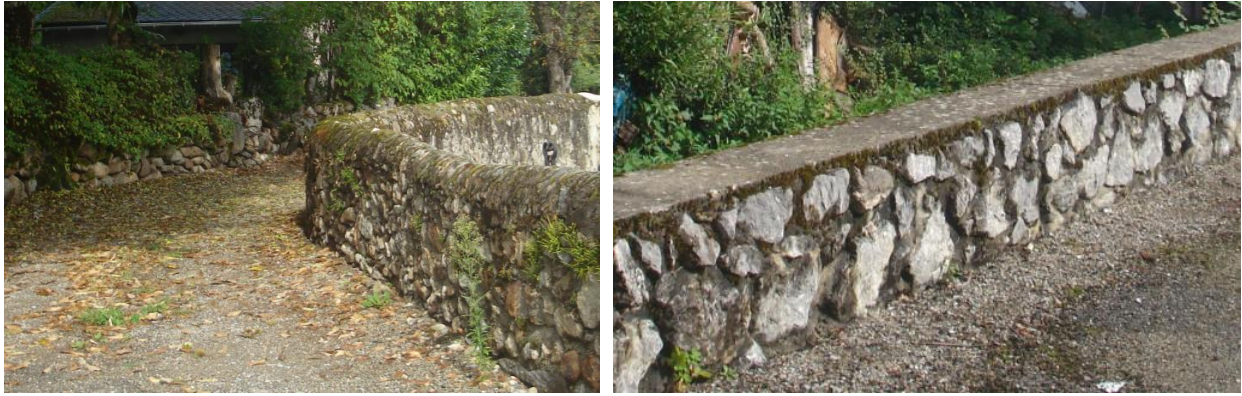
Muret en pierre
