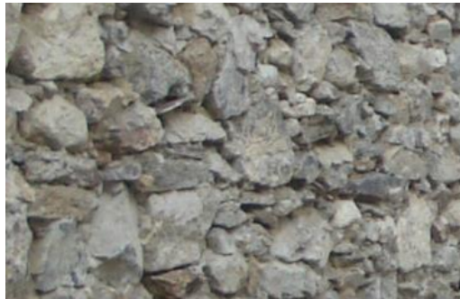
Mur en pierre brute hordée
