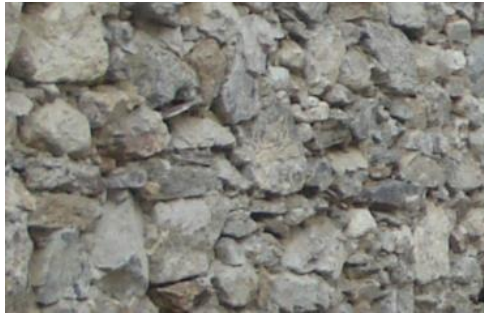
Mur en pierre brute hordée
