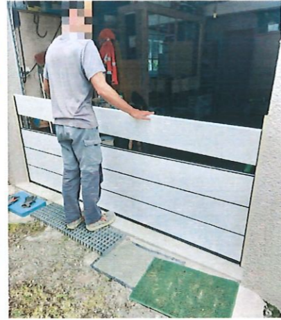
Installation de batardeaux
